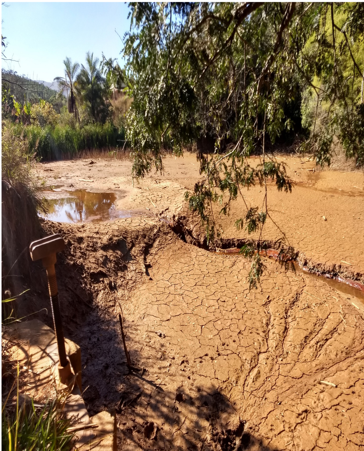
Barragem Tabuões Detalhe Do Material A Ser Retirado
