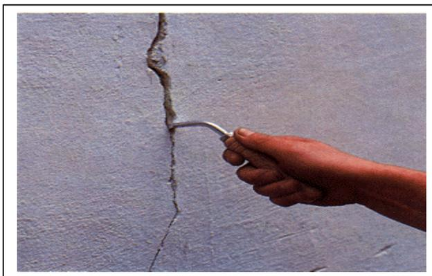
Fig. 08. Abertura da trinca
