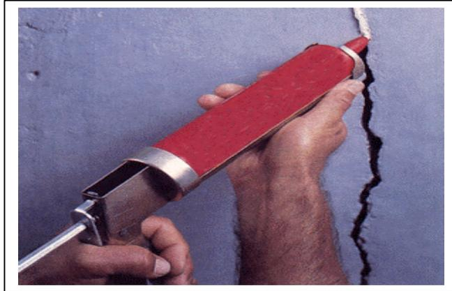
**Fig. 09. Preenchimento da trinca**
