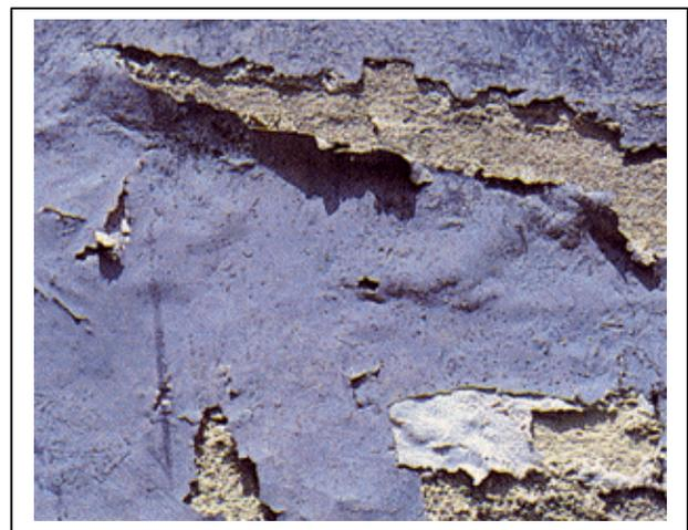
**Fig. 03.** *Desagregamento*
